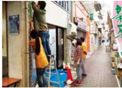
大角橋商店街の店舗施工の様子
